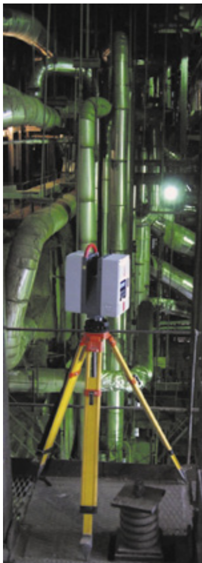
Сканирование трубопроводов на ГРЭС
