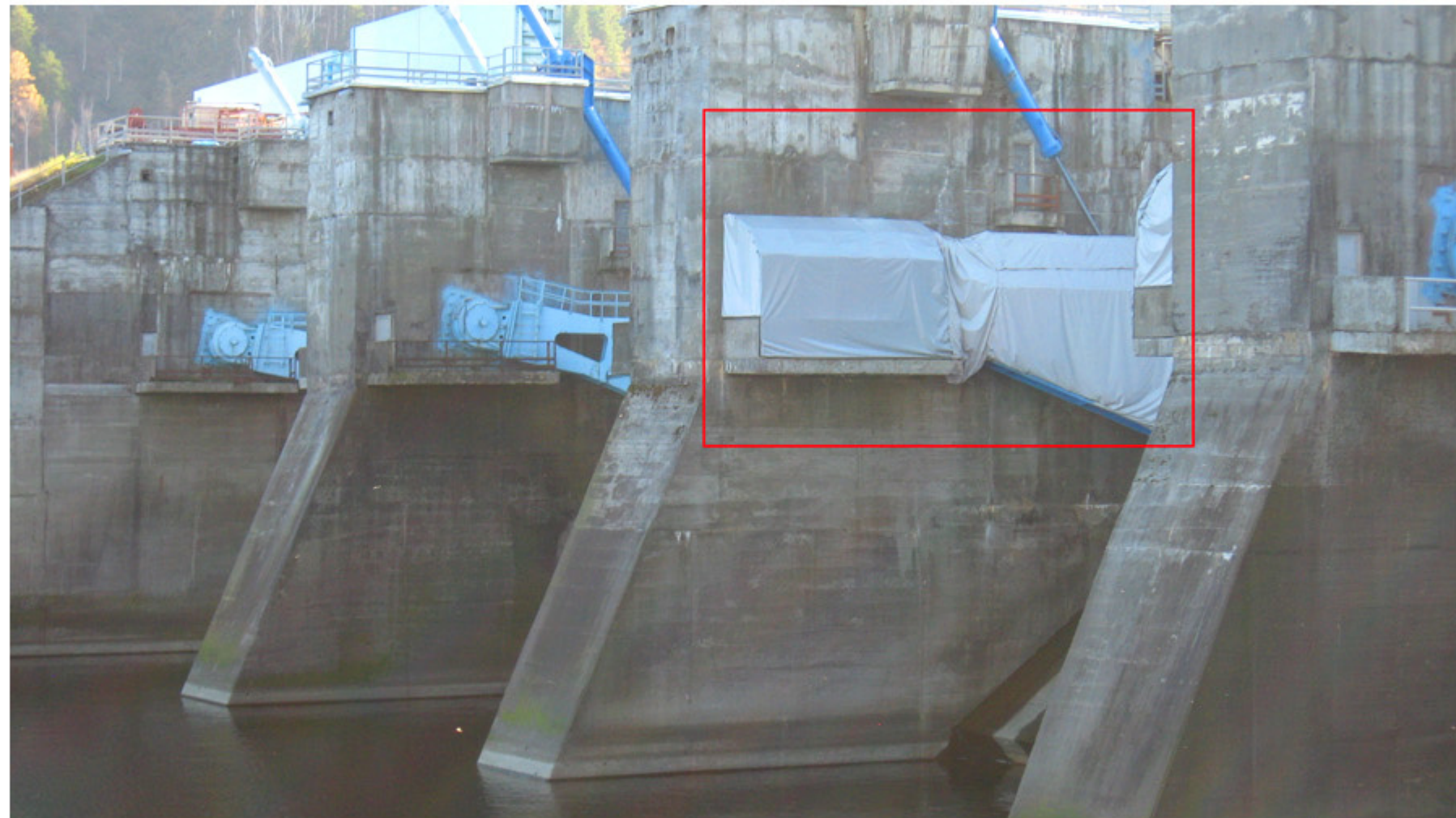
Подъемный механизм затвора плотины, недоступный для сканирования; модель строилась по чертежам Заказчика www.ngce.ru
